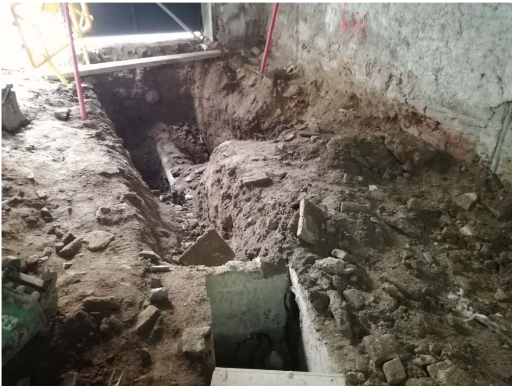
FOTOGRAFIA 8 → Vista de la rasa per reforçar la fonamentació en forma de "L", a l'espai de l'entrada (àmbit-1), des del sud.
