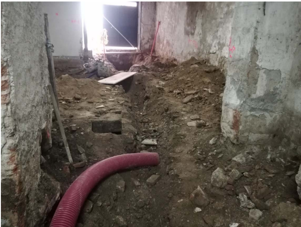
FOTOGRAFIA 10 → Una altra vista de la rasa per evacuar les aigües residuals de la nova construcció vers el clavegueram del carrer, des del sud.
