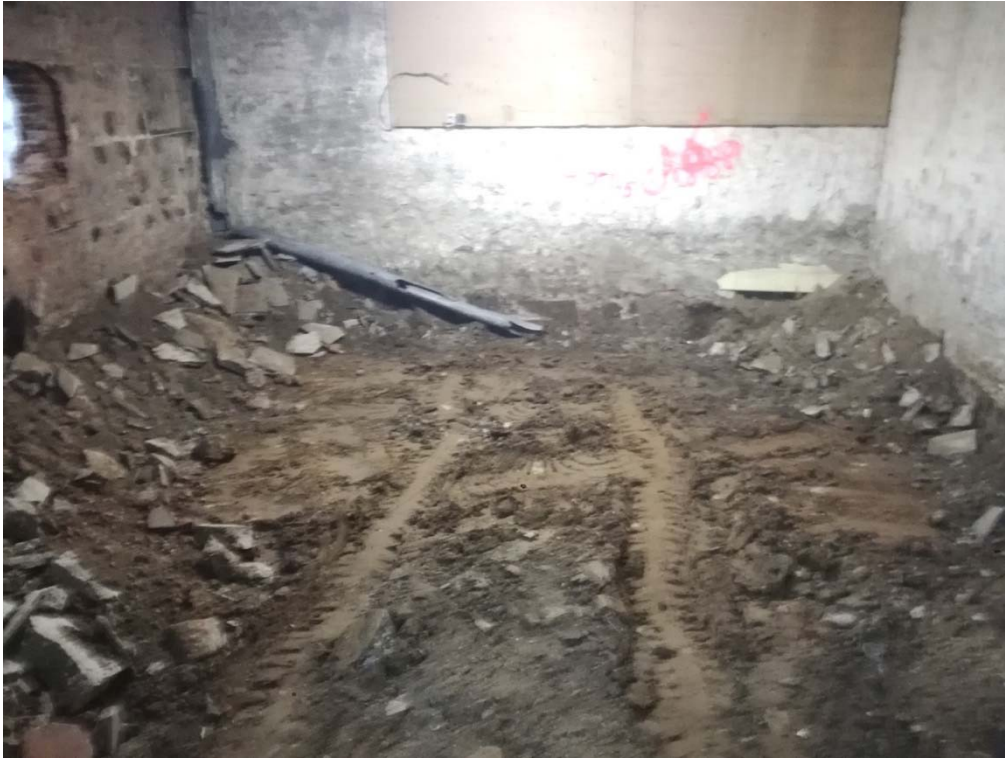
FOTOGRAFIA 5 → Vista final de l'àmbit-4, un cop efectuat el rebaix inicial, des del nord.
