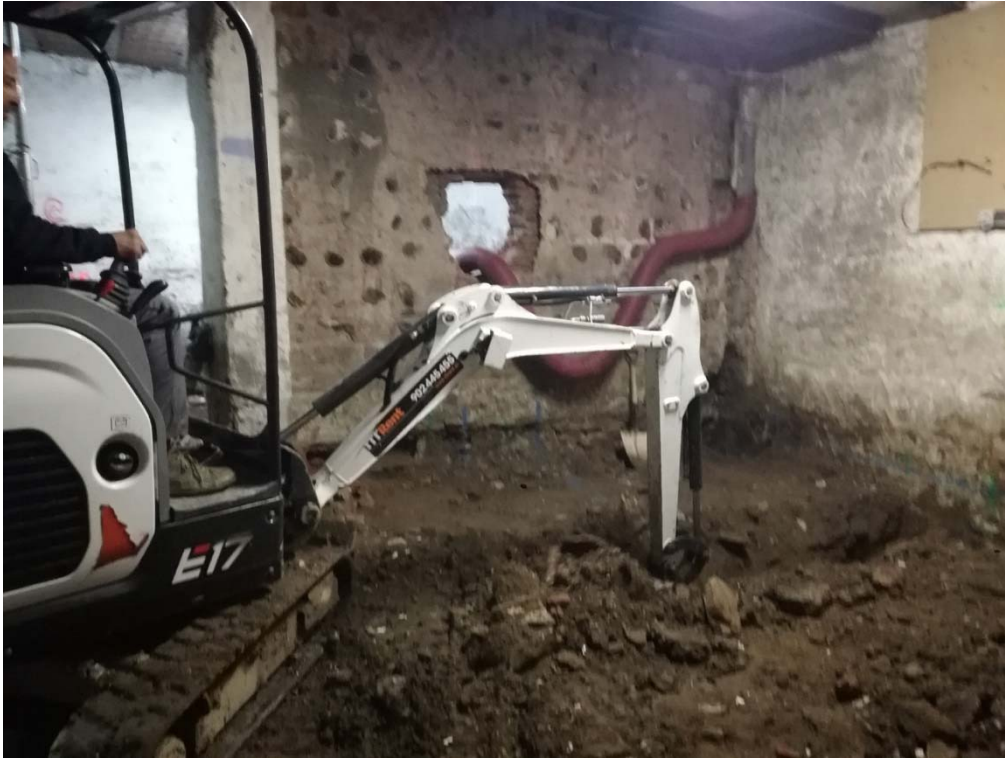
FOTOGRAFIA 7 → Imatge de la màquina giratòria obrint la rasa per efectuar el reforç de la fonamentació a l'àmbit-4, des de l'oest.
