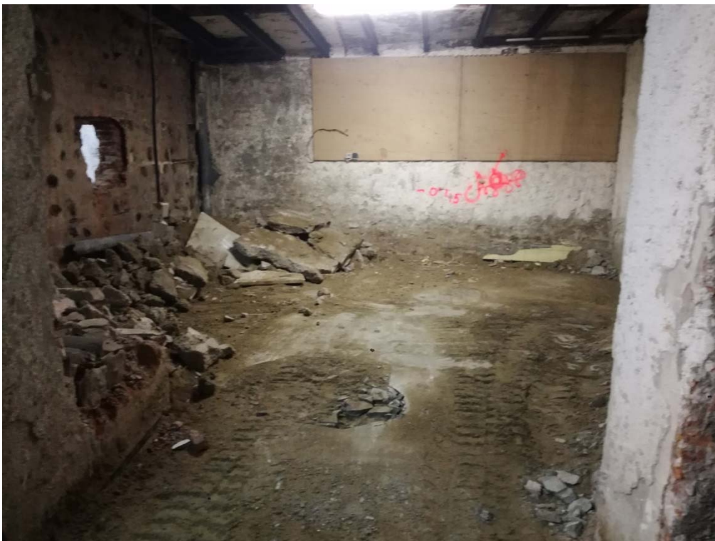
FOTOGRAFIA 4 → Fotografia durant les tasques del rebaix inicial d'uns 40 cm a l'àmbit-4, des del nord.
