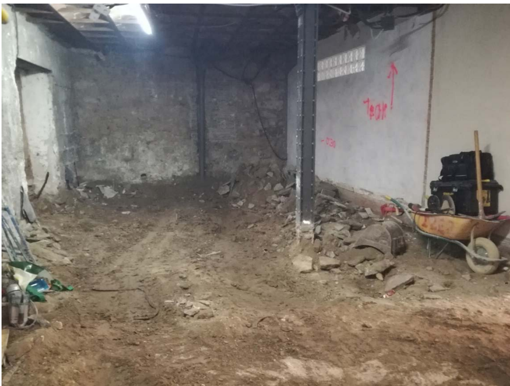
FOTOGRAFIA 6 → Fotografia després del rebaix inicial d'uns 40 cm a l'espai de l'àmbit-2, des de l'est.
